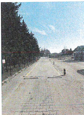
Fot. Nr 4 Przedstawia drogę pożarową na terenie zakładu
