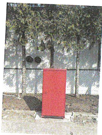
Fot Nr 2 i 3 Przedstawia hydrant podziemny ze skrzynką na armaturę wodną.
