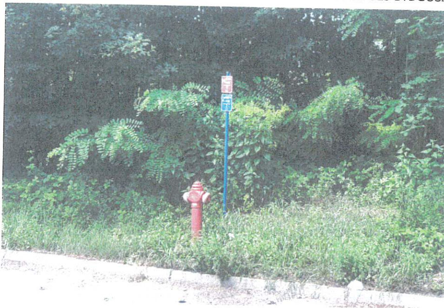
Kolejny hydrant w odległości 75 m od zakładu
