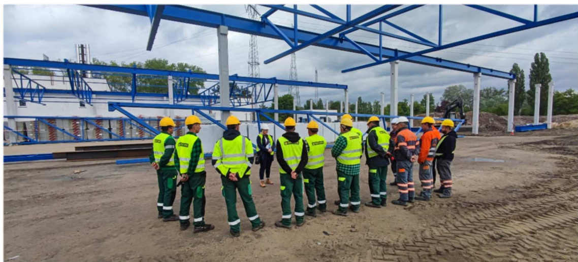
Szkolenie na budowie hali z budynkiem biurowym
