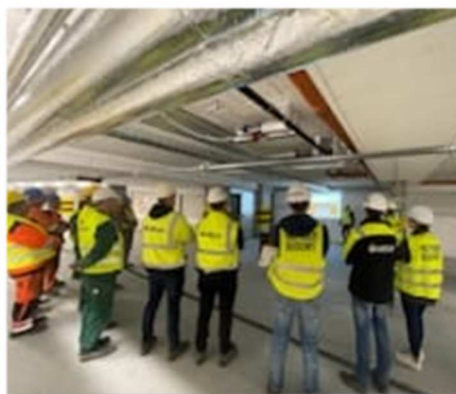
Szkolenie na budowie w Bydgoszczy
