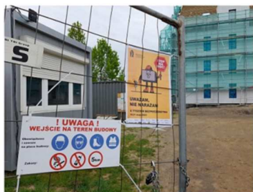
Budowa bloku przy ulicy Puszczykowej w Osiełsku
