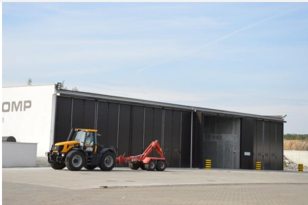
Rysunek 43 Nowa instalacja do biologicznego przetwarzania odpadów, Niedźwiedź (foto: Niedźwiedź, wrzesień 2015r).
