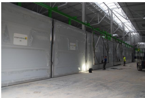
Rysunek 19 Instalacja do stabilizacji i kompostowania -w budowie, Zakurzewo (sierpień 2013r)
