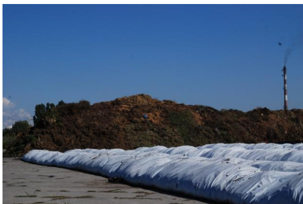
Rysunek 152 Tak było. Instalacja stabilizacji frakcji biodegradowalnej wydzielonej ze zmieszanych odpadów komunalnych, Inowrocław (sierpień 2013r)
