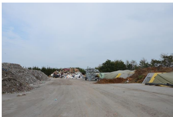
Rysunek 116 Instalacja stabilizacji frakcji biodegradowalnej wydzielonej ze zmieszanych odpadów komunalnych wraz z funkcją kompostowania odpadów zielonych- Służewo (foto: Służewo, wrzesień 2015r)
