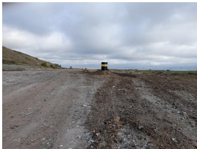
Rysunek 141 Składowisko odpadów – odgazowanie składowiska (foto: październik 2021r)
