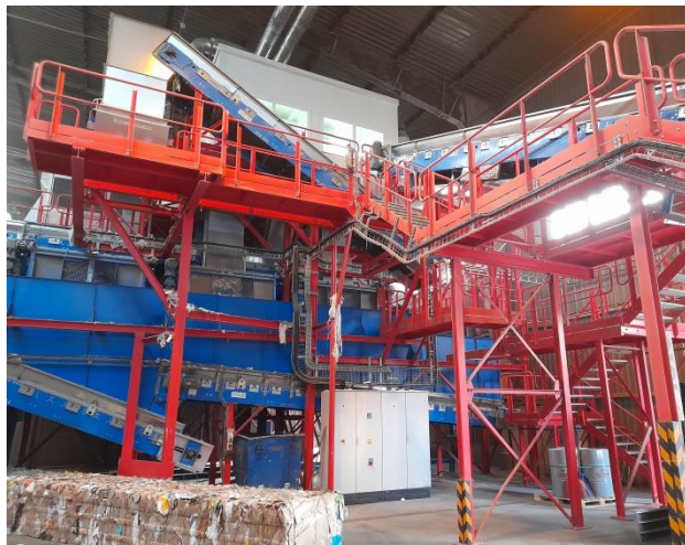
Rysunek 104 Sortownia odpadów komunalnych ProNatura_ Bydgoszcz (foto: Bydgoszcz, październik 2021r.)
