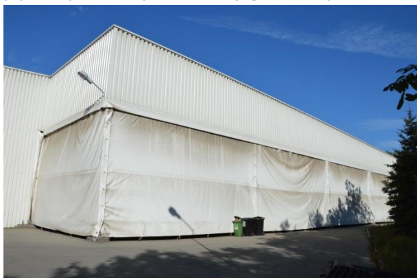
Rysunek 91 Instalacja stabilizacji frakcji biodegradowalnej wydzielonej ze zmieszanych odpadów komunalnych- plac przyzwoły zadaszony i zamknięty kurtyną, Remondis Bydgoszcz (foto: Remondis Bydgoszcz, październik 2015r)
