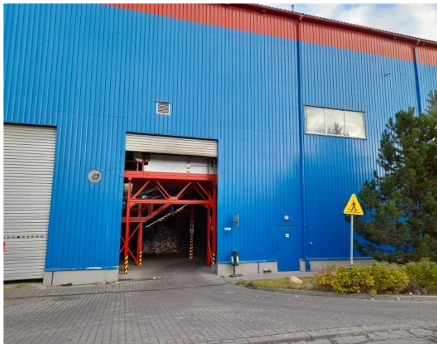
Rysunek 103 Sortownia odpadów komunalnych ProNatura_ Bydgoszcz (foto: Bydgoszcz, październik 2021r.)
