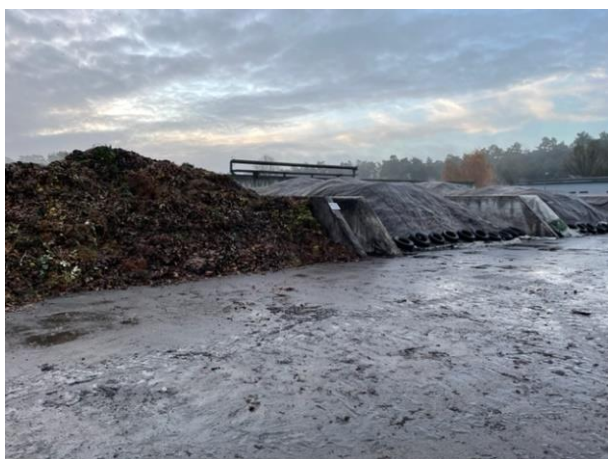
Rysunek 69 Instalacja do biologicznego przetwarzania odpadów z możliwością kompostowania odpadów zielonych, Lipno (foto: października 2021r.).
