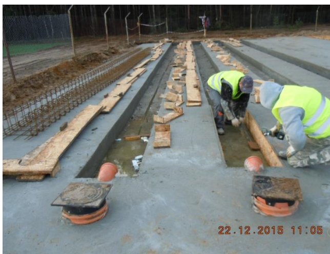
Rysunek 53 Instalacja do biologicznego przetwarzania odpadów, w trakcie budowy, Puszcza Miejska (foto: Puszcza Miejska, grudzień 2015r).
