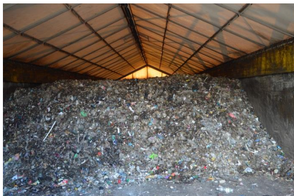
Rysunek 126 Instalacja stabilizacji frakcji biodegradowalnej wydzielonej ze zmieszanych odpadów komunalnych, Toruń MPO (Toruń, MPO, wrzesień 2015r)
