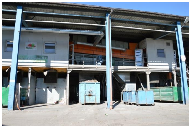
Rysunek 149 Tak jest. Sortownia odpadów komunalnych zmieszanych i częściowo selektywnie zebranych, Inowrocław (fot: Inowrocław. Wrzesień 2015r)
