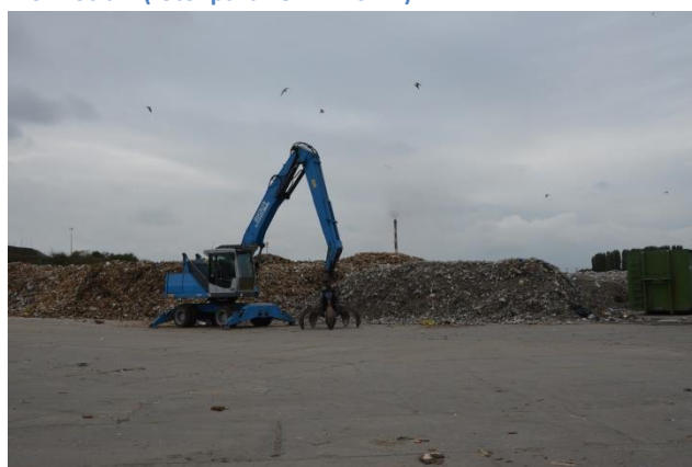
Rysunek 159 Plac dojrzewania stabilizatu, Inowrocław (foto: październik 2021r)
