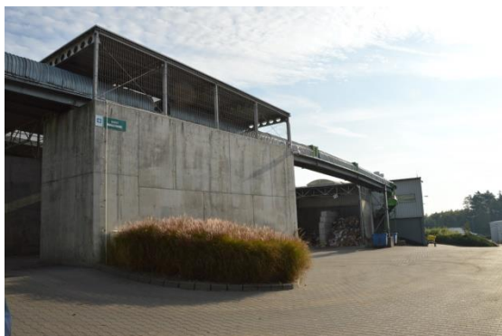
Rysunek 31 Magazyn odpadów surowcowych (foto: Zakurzewo, październik 2021r.)
