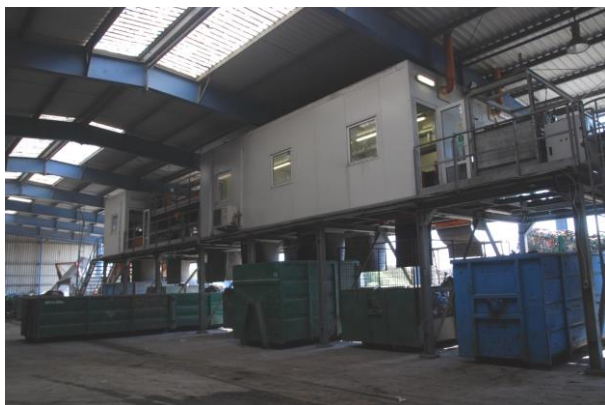
Rysunek 148 Tak było. Sortownia odpadów komunalnych, Inowrocław (sierpień 2013r)
