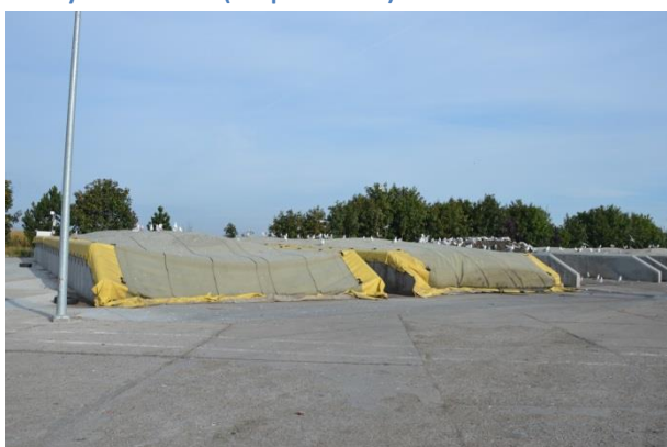
Rysunek 35 Nowa instalacja do biologicznego przetwarzania odpadów z możliwością kompostowania odpadów zielonych, Osnowo (foto: Osnowo, wrzesień 2015r).
