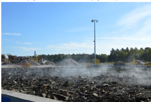
Rysunek 80 Instalacja stabilizacji frakcji biodegradowalnej wydzielonej ze zmieszanych odpadów komunalnych wraz z funkcją kompostowania odpadów zielonych- biofiltr, CORIMP Bydgoszcz (foto: CORIMP Bydgoszcz, październik 2015r)
