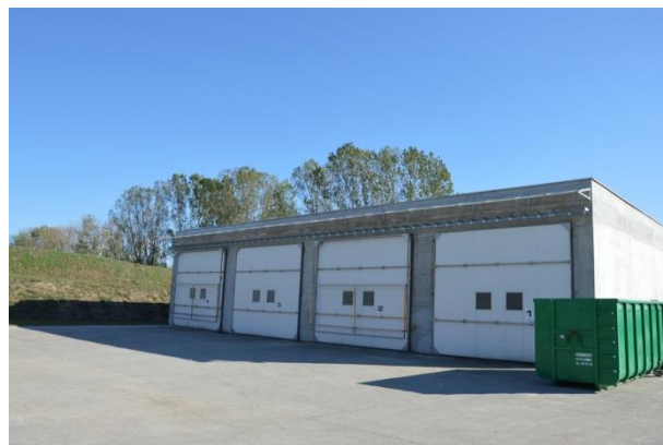
Rysunek 4 Nowa instalacja do biologicznego przetwarzania odpadów z możliwością kompostowania odpadów zielonych, Bładowo (foto: Bładowo, październik 2015r).
