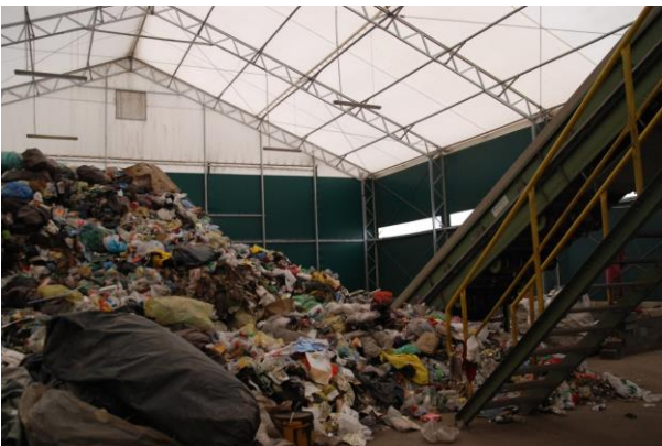
Rysunek 113 Sortownia odpadów komunalnych, Służewo (sierpień 2013r)
