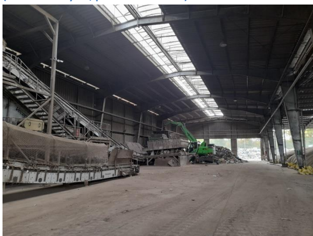
Rysunek 139 Instalacja do rozdrabniania i sortowania po lewej, reaktory stabilizacji biologicznej po prawej (foto: październik 2021r)
