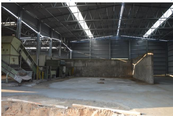
Rysunek 45 Sortownia odpadów komunalnych w trakcie rozbudowy, Niedźwiedź (październik 2021r.)
