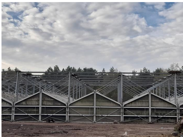
Rysunek 131 Instalacja stabilizacji i/lub kompostowania, Toruń MPO (października 2021r)
