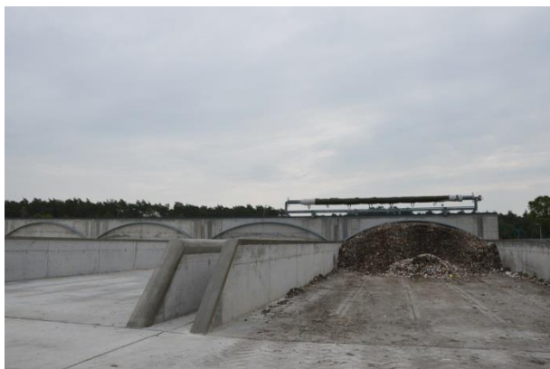
Rysunek 63 Nowa instalacja do biologicznego przetwarzania odpadów z możliwością kompostowania odpadów zielonych, Lipno (foto: Lipno, wrzesień 2015r).
