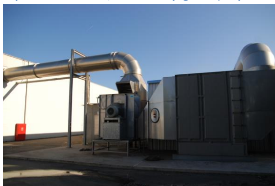
Rysunek 88 Instalacja stabilizacji frakcji biodegradowalnej wydzielonej ze zmieszanych odpadów komunalnych-napełnianie reaktorów, Remondis Bydgoszcz (sierpień 2013r)
