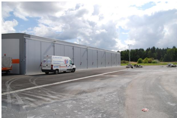
Rysunek 77 Instalacja stabilizacji frakcji biodegradowalnej wydzielonej ze zmieszanych odpadów komunalnych - faza rozruchu, CORIMP Bydgoszcz (sierpień 2013r.)
