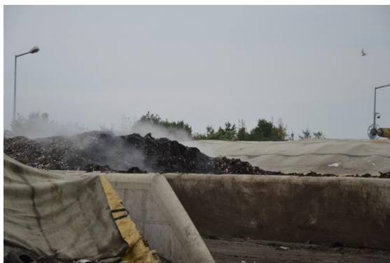
Rysunek 76 Instalacja do biologicznego przetwarzania odpadów z możliwością kompostowania odpadów zielonych, Machnacz (foto: Machnacz, wrzesień 2015r.)
