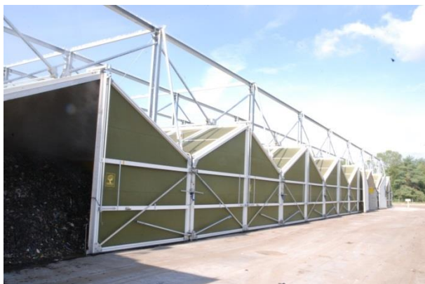
Rysunek 125 Instalacja stabilizacji frakcji biodegradowalnej wydzielonej ze zmieszanych odpadów komunalnych, Toruń MPO (sierpień 2013r)
