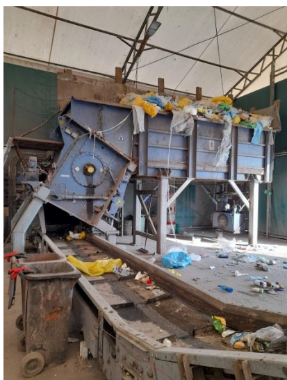
Rysunek 119 Sortownia odpadów zmieszanych i selektywnie zebranych- rozrywarka worków, Służewo (foto: Służewo, październik 2021r.)
