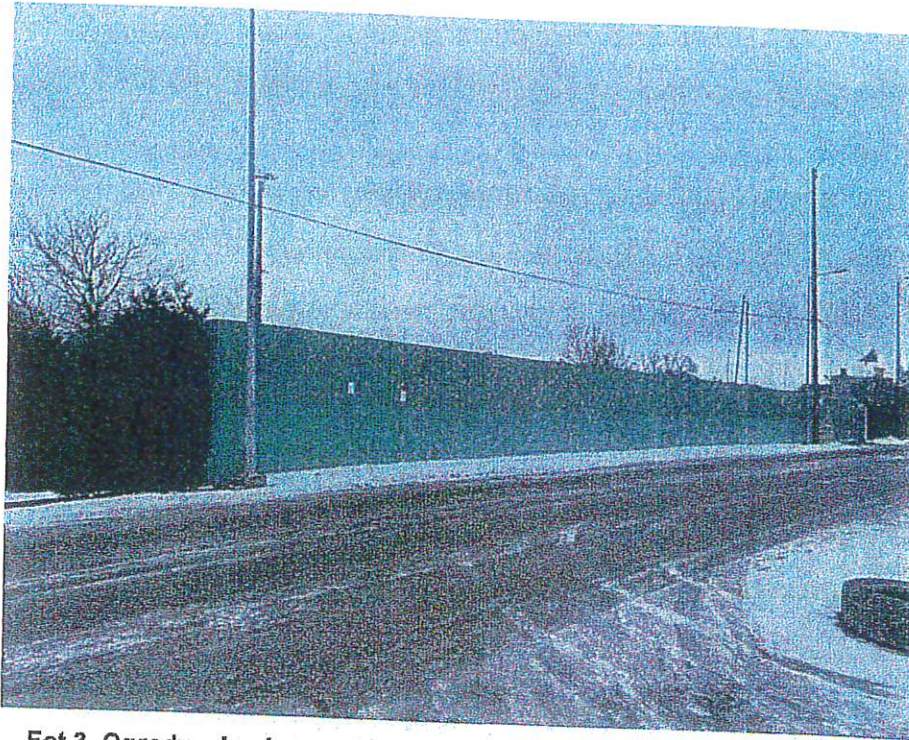
Fot.3 Ogrodzenie placu składowego zakładu P.U.H. „Maxicar” Marcin Zalewski w Pakości.
