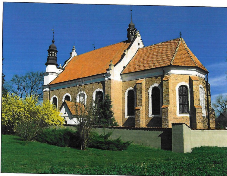
Fot. 19 Kościół parafialny w Topolnie wybudowany w latach 1681-1683(fot. R. Gonia).
