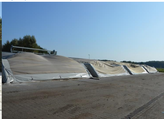
Rysunek 58 Instalacja do biologicznego przetwarzania odpadów z możliwością kompostowania odpadów zielonych, Puszczka Miejska (foto: Puszczka Miejska, październik 2021r.)
