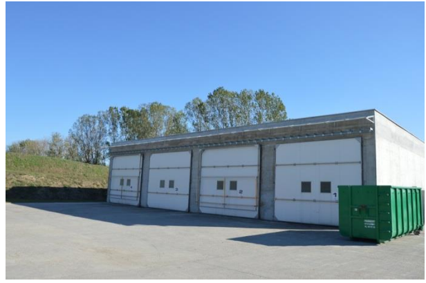
Rysunek 4 Nowa instalacja do biologicznego przetwarzania odpadów z możliwością kompostowania odpadów zielonych, Bładowo (foto: Bładowo, październik 2015r).
