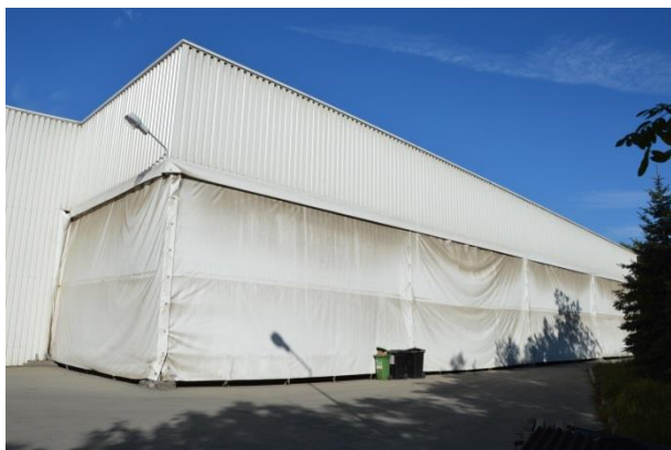
Rysunek 91 Instalacja stabilizacji frakcji biodegradowalnej wydzielonej ze zmieszanych odpadów komunalnych- plac przykryty białą kurtyną, Remondis Bydgoszcz (foto: Remondis Bydgoszcz, październik 2015r)
