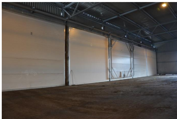
Rysunek 92 Instalacja stabilizacji frakcji biodegradowalnej wydzielonej ze zmieszanych odpadów komunalnych- obudowa hermetyzująca, Remondis Bydgoszcz (foto: Remondis Bydgoszcz, październik 2015r.)
