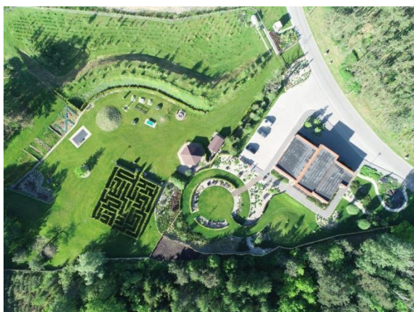
Rysunek 29 Widok centrum edukacji ekologicznej przy zakładzie w Zakurzewie (foto od zakładu, Zakurzewo, październik 2021r.).
