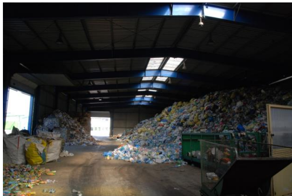
Rysunek 157 Sortownia odpadów surowcowych, Inowrocław (foto: sierpień 2013r)
