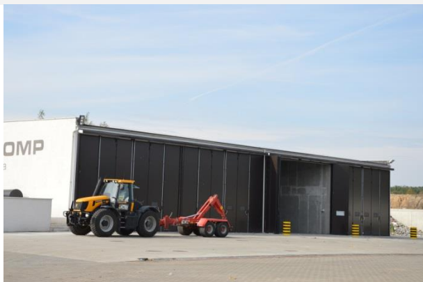
Rysunek 43 Nowa instalacja do biologicznego przetwarzania odpadów, Niedźwiedź (foto: Niedźwiedź, wrzesień 2015r).
