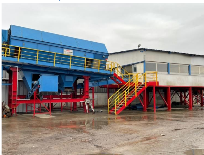
Rysunek 67 Nowa sortownia odpadów komunalnych, Lipno – (foto. Październik 2021r.)
