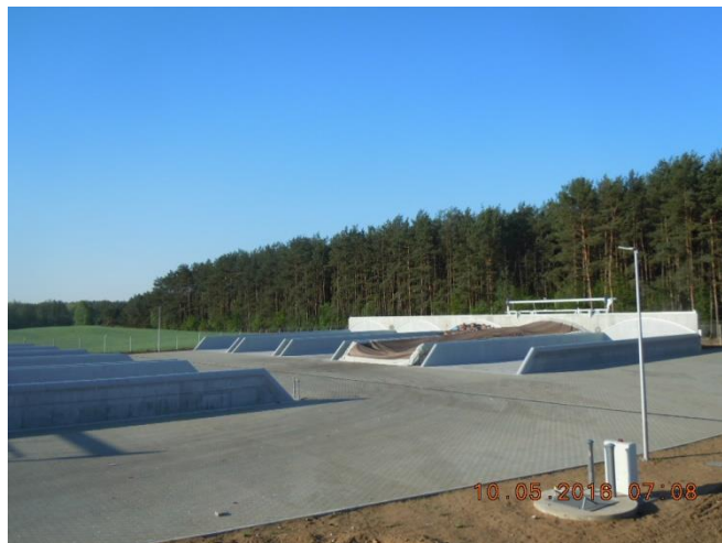
Rysunek 54 Nowa instalacja do biologicznego przetwarzania odpadów z możliwością kompostowania odpadów zielonych, Puszczza Miejska (foto: Puszczza Miejska, marzec 2016r).
