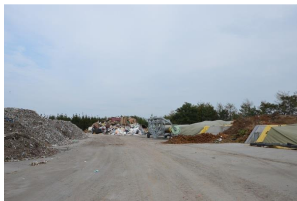
Rysunek 118 Instalacja stabilizacji frakcji biodegradowalnej wydzielonej ze zmieszanych odpadów komunalnych wraz z funkcją kompostowania odpadów zielonych- Służewo (foto: Służewo, wrzesień 2015r)
