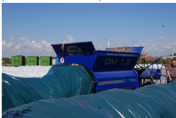
Rysunek 153 Tak było. Instalacja stabilizacji frakcji biodegradowalnej wydzielonej ze zmieszanych odpadów komunalnych- system rękawów foliowych, Inowrocław (sierpień 2013r) zlikwidowana
