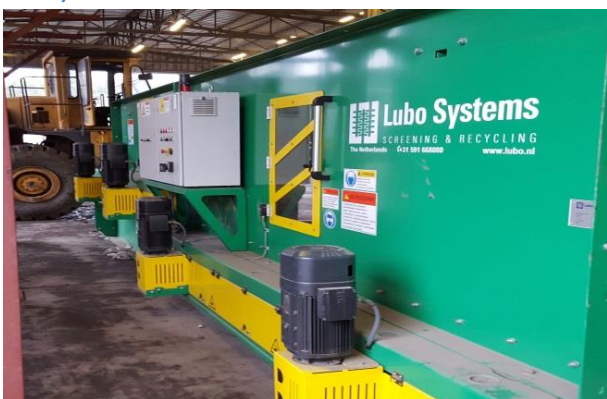
Rysunek 61 Sortownia w Lipnie w trakcie modernizacji (foto: Lipno, październik 2015r).
