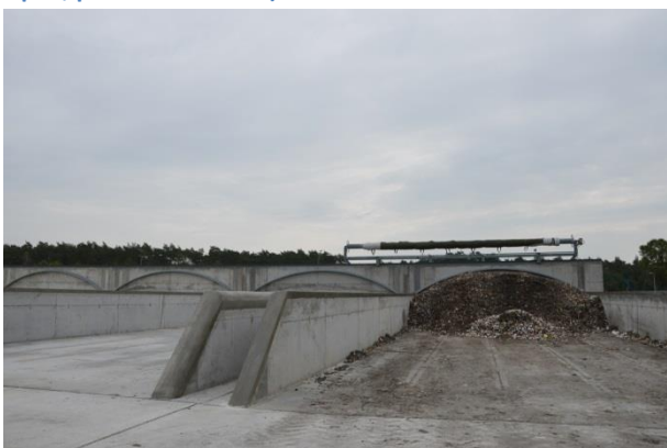
Rysunek 63 Nowa instalacja do biologicznego przetwarzania odpadów z możliwością kompostowania odpadów zielonych, Lipno (foto: Lipno, wrzesień 2015r).
