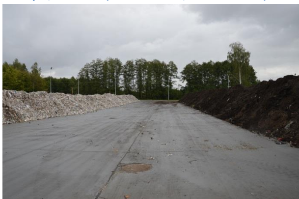
Rysunek 11 Nowa kompostownia polowa odpadów zielonych oraz plac dojrzewania stabilizatu, Sulnówko (foto: Sulnówko, wrzesień 2015r).
