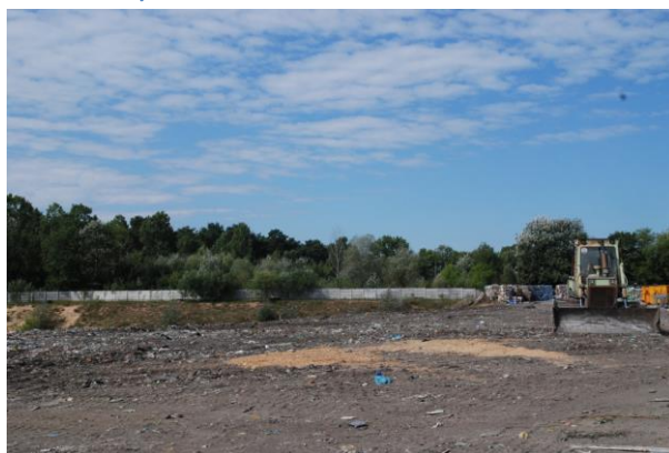
Rysunek 64 Składowisko odpadów, Lipno (sierpień 2013r)
