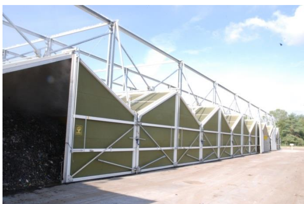
Rysunek 127 Instalacja stabilizacji frakcji biodegradowalnej wydzielonej ze zmieszanych odpadów komunalnych, Toruń MPO (sierpień 2013r)
