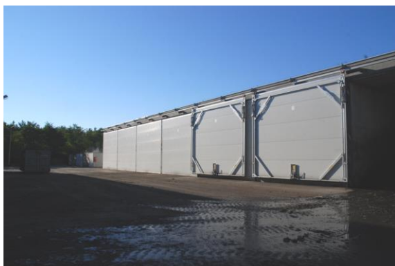
Rysunek 87 Instalacja stabilizacji frakcji biodegradowalnej wydzielonej ze zmieszanych odpadów komunalnych- bioreaktory, Remondis Bydgoszcz (sierpień 2013r)
