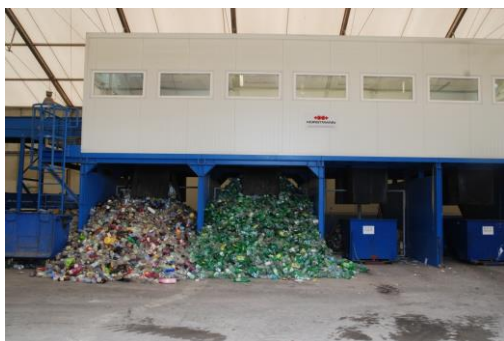
Rysunek 33 Sortownia odpadów komunalnych, Osnowo – kabiny sortownicze (sierpień 2013r)
