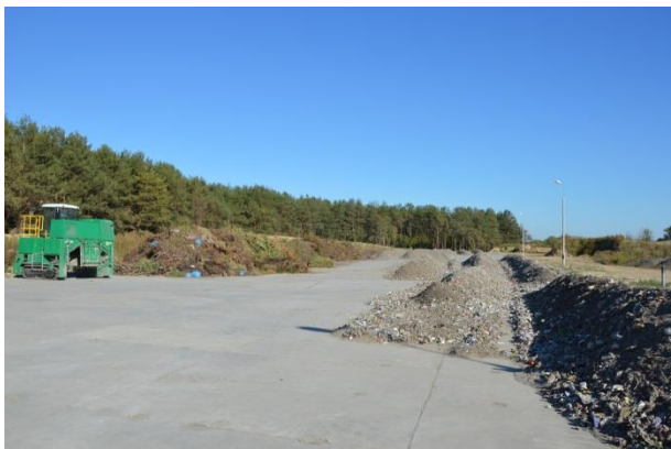
Rysunek 5 Nowa polowa kompostowania odpadów zielonych wraz z placem dojrzewania stabilizatu, Bładowo (foto: Bładowo, październik 2015r).
