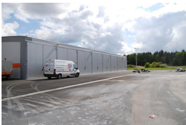
Rysunek 77 Instalacja stabilizacji frakcji biodegradowalnej wydzielonej ze zmieszanych odpadów komunalnych - faza rozruchu, CORIMP Bydgoszcz (sierpień 2013r.)
