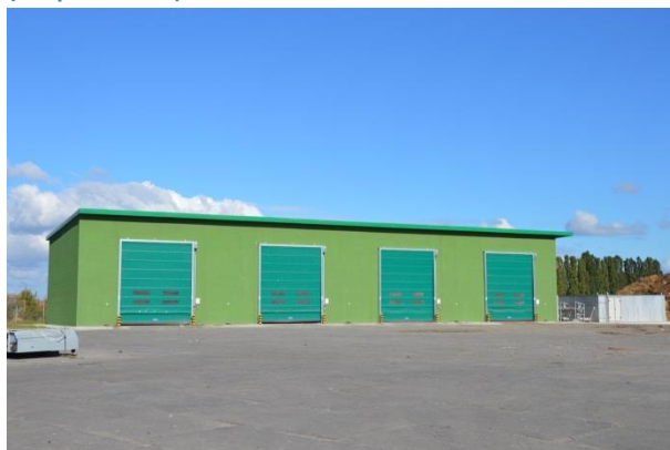
Rysunek 155 Instalacja stabilizacji frakcji biodegradowalnej wydzielonej ze zmieszanych odpadów komunalnych,
