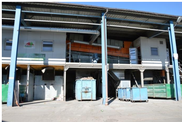
Rysunek 151 Tak jest. Sortownia odpadów komunalnych zmieszanych i częściowo selektywnie zebranych, Inowrocław (fot: Inowrocław. Wrzesień 2015r)
