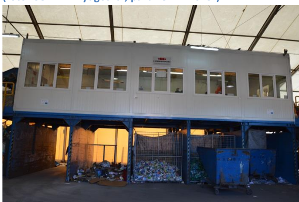
Rysunek 82 Sortownia odpadów komunalnych, CORIMP Bydgoszcz (foto: CORIMP Bydgoszcz, październik 2015r)
