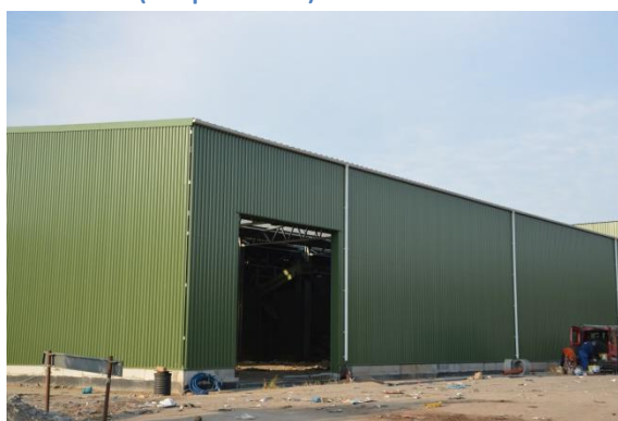
Rysunek 46 Hala sortowni odpadów komunalnych w trakcie rozbudowy, Niedźwiedź (październik 2021r.)
