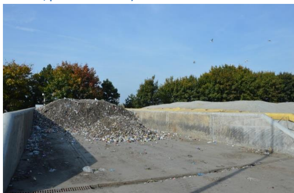
Rysunek 40 Instalacja do biologicznego przetwarzania odpadów z możliwością kompostowania odpadów zielonych, Osnowo (foto: Osnowo, październik 2021r).
