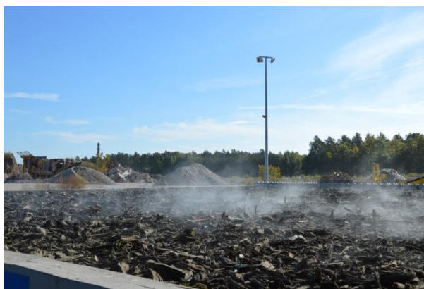
Rysunek 80 Instalacja stabilizacji frakcji biodegradowalnej wydzielonej ze zmieszanych odpadów komunalnych wraz z funkcją kompostowania odpadów zielonych- biofiltr, CORIMP Bydgoszcz (foto: CORIMP Bydgoszcz, październik 2015r)
