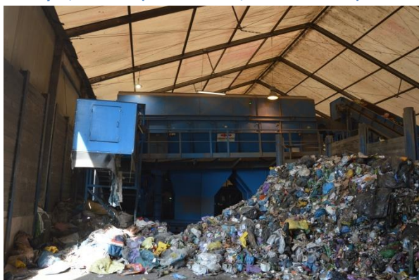
Rysunek 37 Sortownia odpadów (komunalnych zmieszanych i surowcowych), Osnowo (foto: Osnowo, październik 2021).
