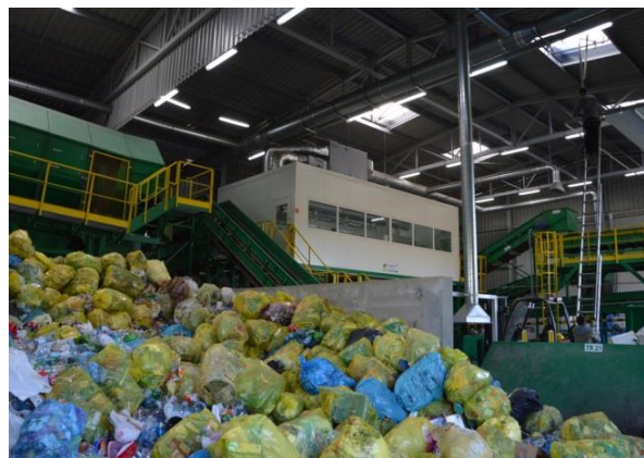
Rysunek 2 Nowa sortownia odpadów komunalnych (zmieszanych i surowcowych), Bładowo (foto: Bładowo, październik 2015r).
