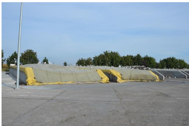
Rysunek 35 Nowa instalacja do biologicznego przetwarzania odpadów z możliwością kompostowania odpadów zielonych, Osnowo (foto: Osnowo, wrzesień 2015r).
