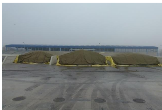
Rysunek 72 Nowa instalacja do biologicznego przetwarzania odpadów z możliwością kompostowania odpadów zielonych, Machnacz (foto: Machnacz, wrzesień 2015r.)
