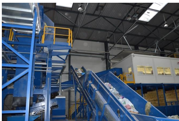
Rysunek 10 Nowa sortownia odpadów (komunalnych zmieszanych i surowcowych), Sulnówko (foto: Sulnówko, wrzesień 2015r).
