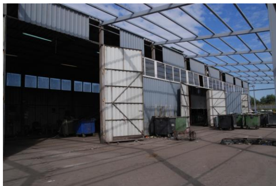
Rysunek 60 Sortownia odpadów komunalnych, Lipno – rozbudowa budynku (sierpień 2013r)
