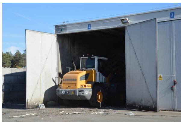
Rysunek 78 Instalacja stabilizacji frakcji biodegradowalnej wydzielonej ze zmieszanych odpadów komunalnych wraz z funkcją kompostowania odpadów zielonych- faza eksploatacji, CORIMP Bydgoszcz (foto: CORIMP Bydgoszcz, październik 2015r.)
