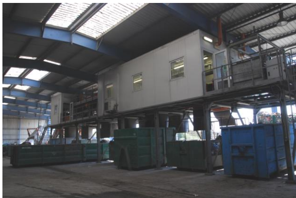
Rysunek 150 Tak było. Sortownia odpadów komunalnych, Inowrocław (sierpień 2013r)
