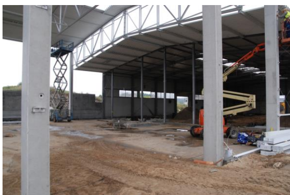
Rysunek 17 Rozbudowa budynku sortowni, Zakurzewo (sierpień 2013r)
