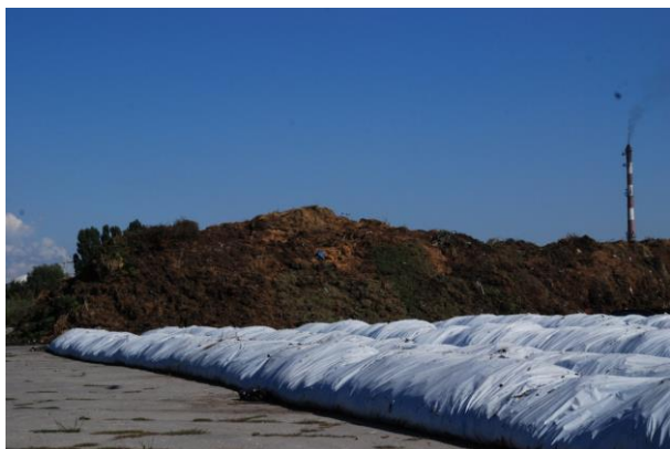
Rysunek 154 Tak było. Instalacja stabilizacji frakcji biodegradowalnej wydzielonej ze zmieszanych odpadów
