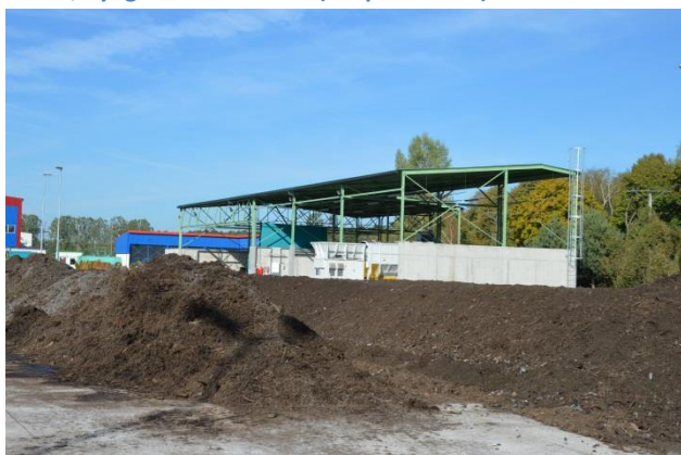
Rysunek 101 Kompostowania odpadów zielonych, Bydgoszcz ProNatura (foto: Bydgoszcz, październik 2015r)
