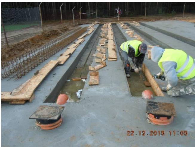
Rysunek 53 Instalacja do biologicznego przetwarzania odpadów, w trakcie budowy, Puszczza Miejska (foto: Puszczza Miejska, grudzień 2015r).
