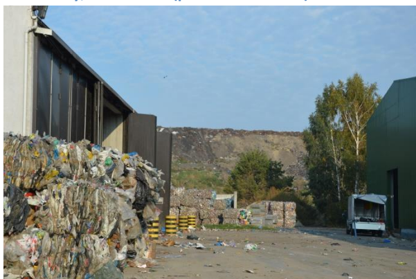
Rysunek 47 Instalacja do biologicznego przetwarzania odpadów, Niedźwiedź (foto: Niedźwiedź, wrzesień 2015r).
