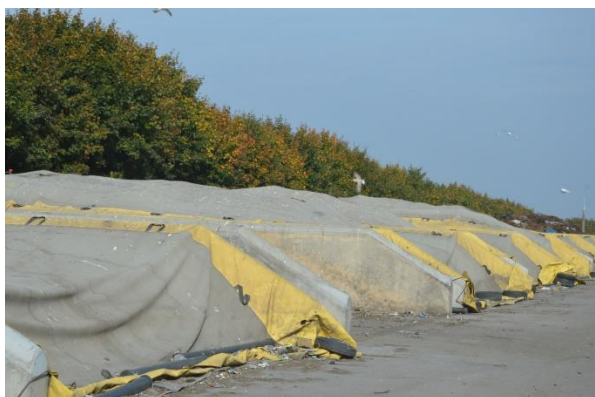
Rysunek 39 Instalacja do biologicznego przetwarzania odpadów z możliwością kompostowania odpadów zielonych, Osnowo (foto: Osnowo, październik 2021r).
