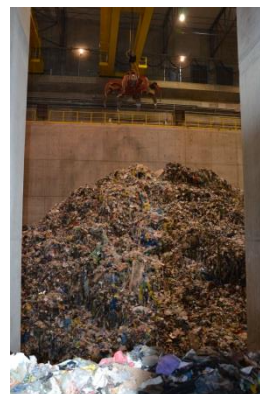
Rysunek 112 Spalarnia odpadów komunalnych, bunkier zasypowy odpadów, Bydgoszcz ProNatura ZTPOK (foto: Bydgoszcz, październik 2015r)
