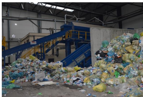
Rysunek 8 Nowa sortownia odpadów (komunalnych zmieszanych i surowcowych), Sulnówko (foto: Sulnówko, wrzesień 2015r).
