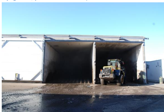
Rysunek 88 Instalacja stabilizacji frakcji biodegradowalnej wydzielonej ze zmieszanych odpadów komunalnych- napełnianie rektorów, Remondis Bydgoszcz (sierpień 2013r)
