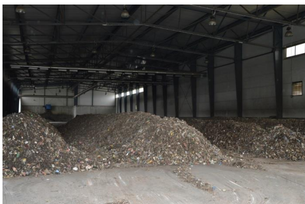
Rysunek 9 Nowa instalacja do biologicznego przetwarzania odpadów z możliwością kompostowania odpadów zielonych, Sulnówko (foto: Sulnówko, wrzesień 2015r).
