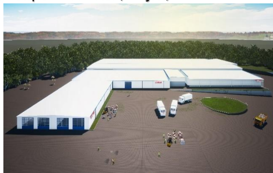
Hermetyzacja i modernizacja instalacji do mechanicznego i biologicznego przetwarzania odpadów komunalnych w REMONDIS Bydgoszcz S.A (III miejsce)
