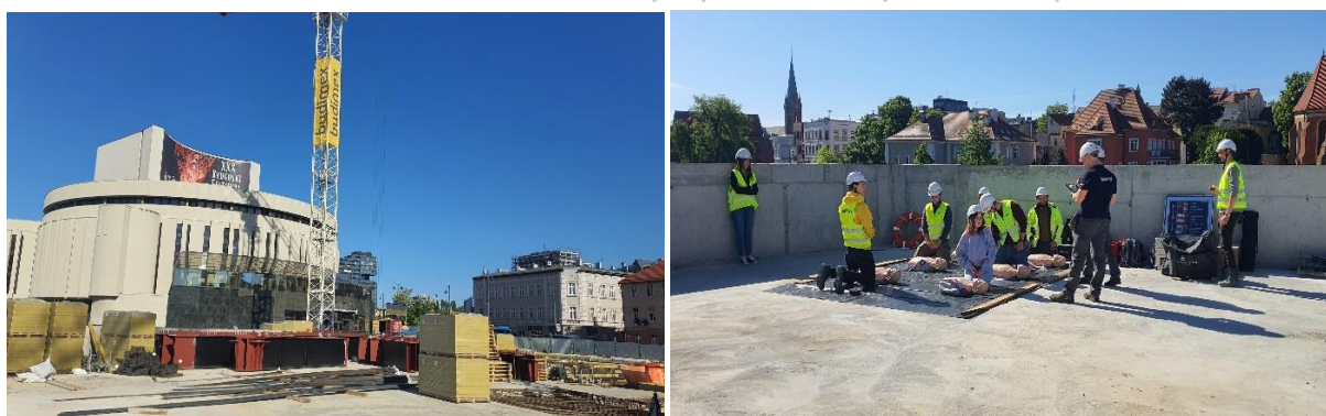
Budowa 4 kręgu Opery Nova w Bydgoszczy i szkolenie z pierwszej pomocy na placu budowy
