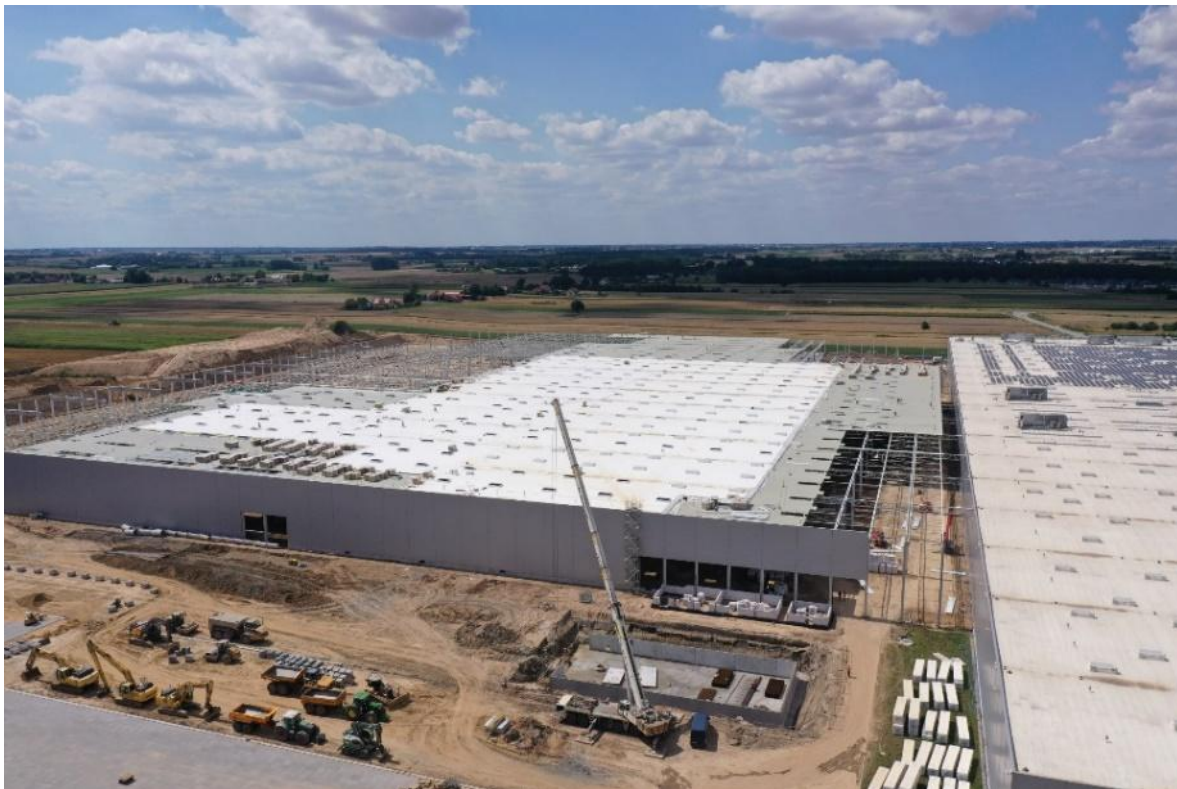
Rozbudowa Centrum Dystrybucyjnego - Etap 2 w Machnacu (I miejsce)
