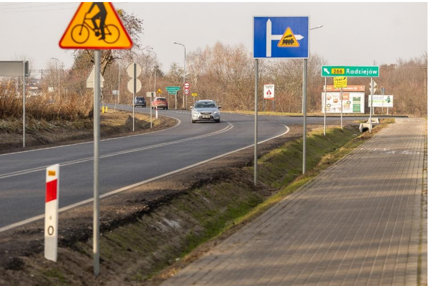
Droga wojewódzka nr 266 po odnowie nawierzchni, fot. Szymon Zdziebło
