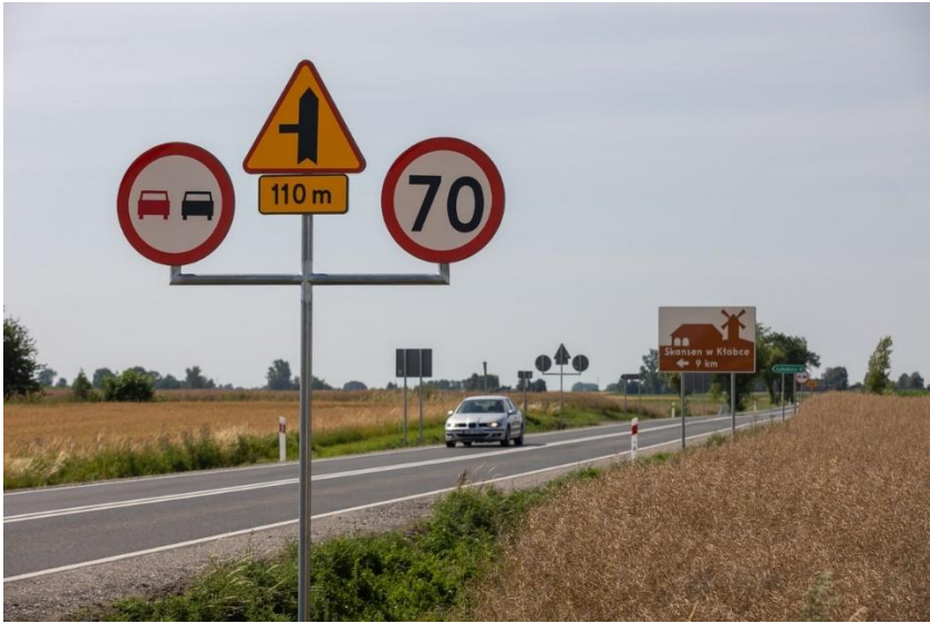
Przebudowana droga wojewódzka nr 269, fot. Michał Sitarek
