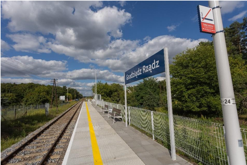
Nowy przystanek kolejowy Grudziądz Rządź na linii kolejowej nr 207, fot. Mikołaj Kuras
