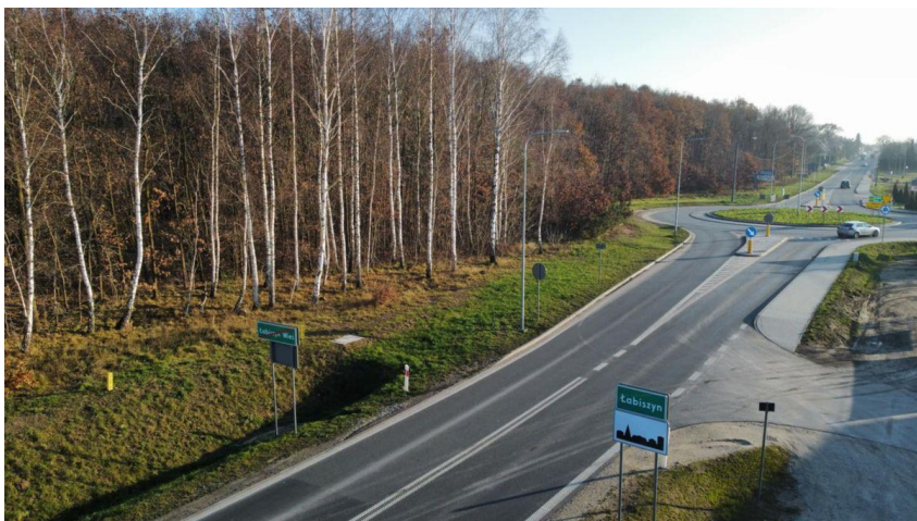
Przebudowana droga wojewódzka nr 254, fot. Michał Sitarek
