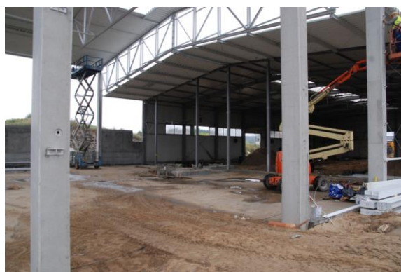
Rysunek 17 Rozbudowa budynku sortowni, Zakurzewo (sierpień 2013r)
