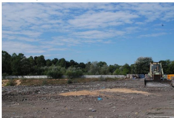
Rysunek 64 Składowisko odpadów, Lipno (sierpień 2013r)
