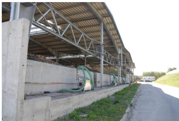
Rysunek 138 Instalacja do stabilizacji biologicznej odpadów – proces suszenia, Wawrzynki (sierpień 2013r)
