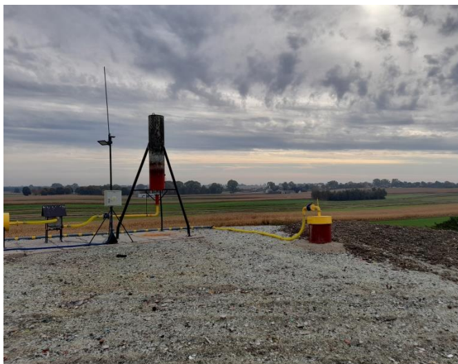
Rysunek 123 Pochodnia systemu odgazowania kwater nr 3 (foto: Służewo, październik 2021r.)
