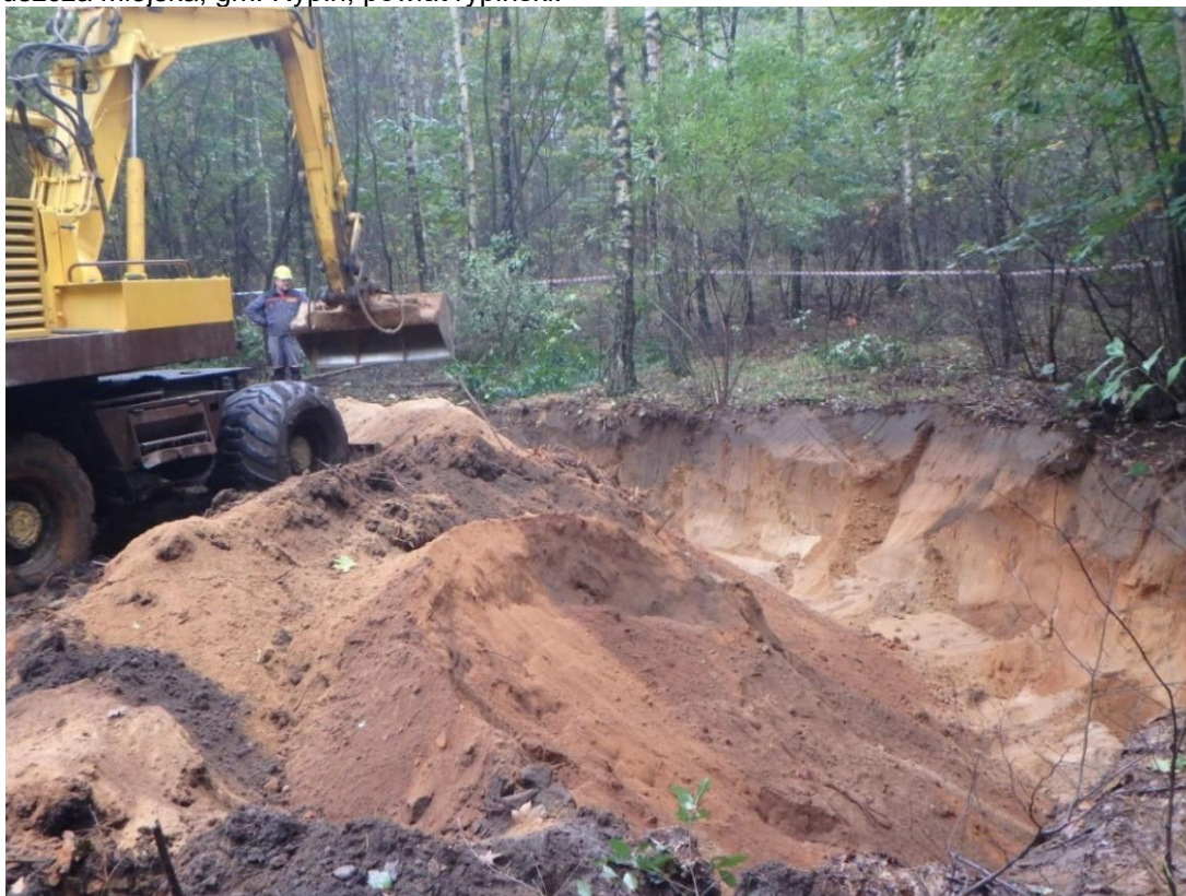
Zdjęcie nr 2. Wizja terenowa w dniu 13.10.2020 r.- usuwanie ziemi zanieczyszczonej substancjami ropopochodnymi z miejsca uszkodzonego rurociągu „Pomorskiego” PERN S.A. w m. Puszcza Miejska, gm. Rypin, powiat rypiński.
