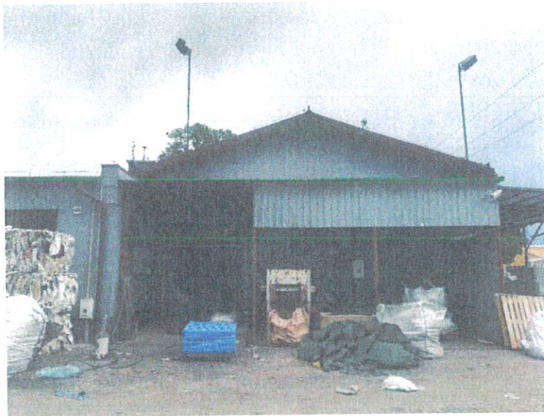
Widok na halę produkcyjną – od strony zachodniej
