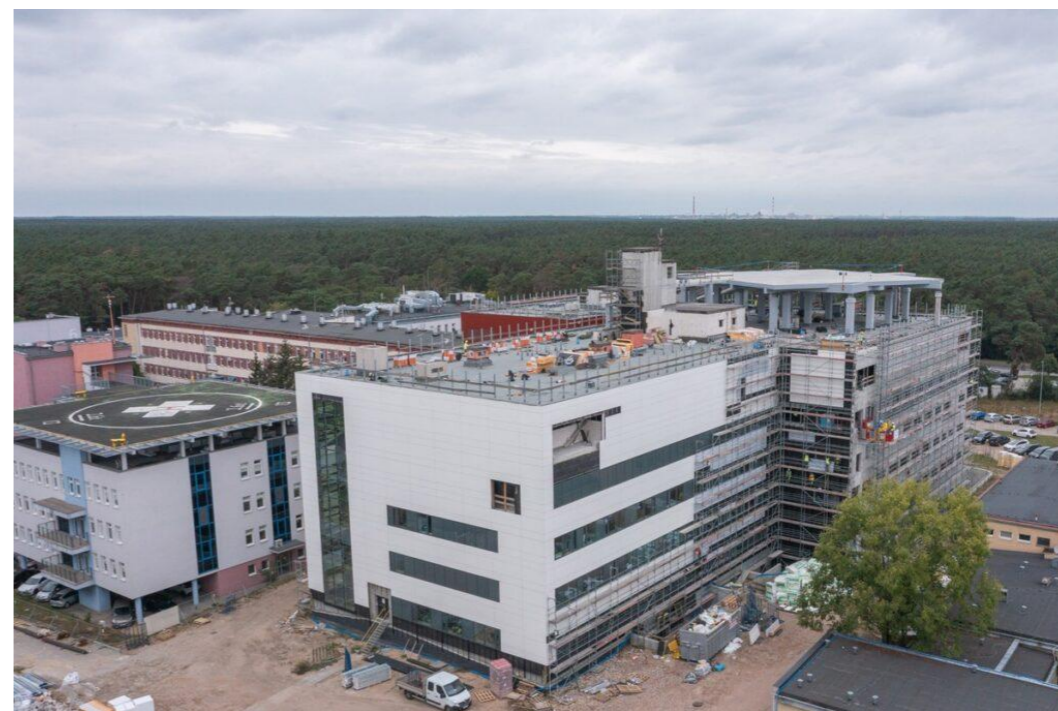
Budowa Wojewódzkiego Szpitala Specjalistycznego we Włocławku, 9 października 2025 r., fot. Mikołaj Kuras
