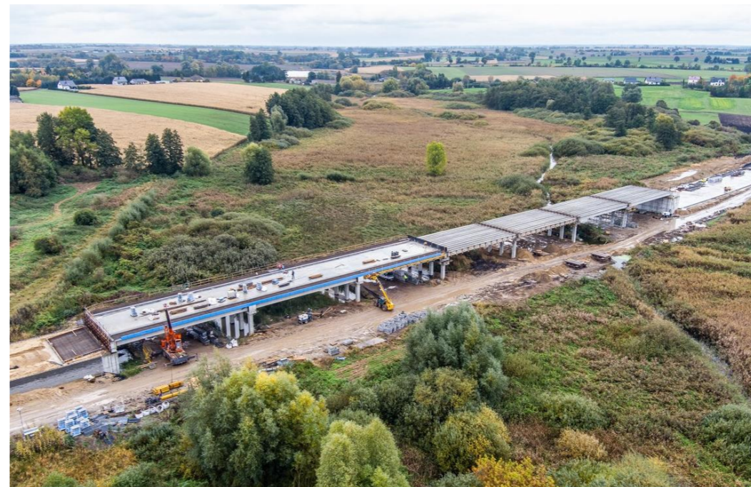
Budowa Obwodnicy Mogilna, 19 listopada 2025 r., fot. Andrzej Goiński
