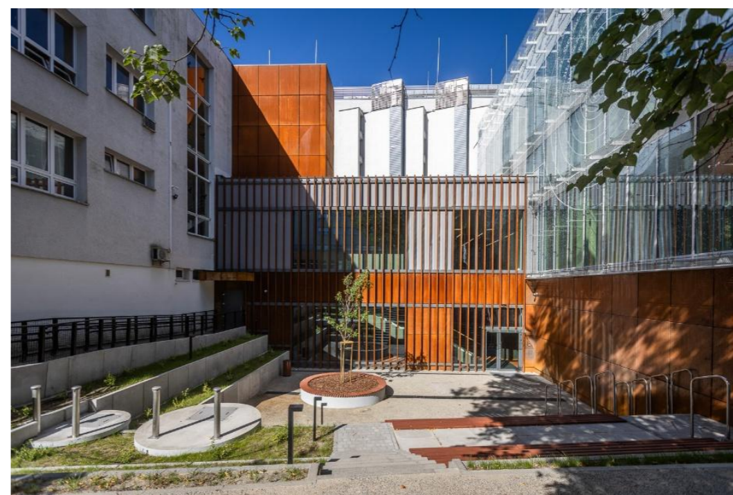
Rozbudowany budynek Książnicy Kopernikańskiej, fot. Szymon Zdziebło
