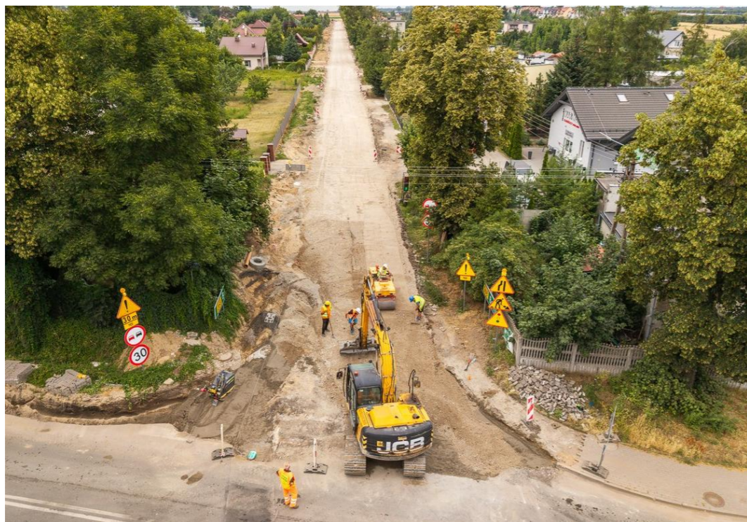
Poprawa warunków obsługi i rozwoju Brzeskiej Strefy Gospodarczej poprzez modernizację DW 268 – Zwiększenie bezpieczeństwa ruchu drogowego, czerwiec 2025 r., fot. Michał Sitarek
