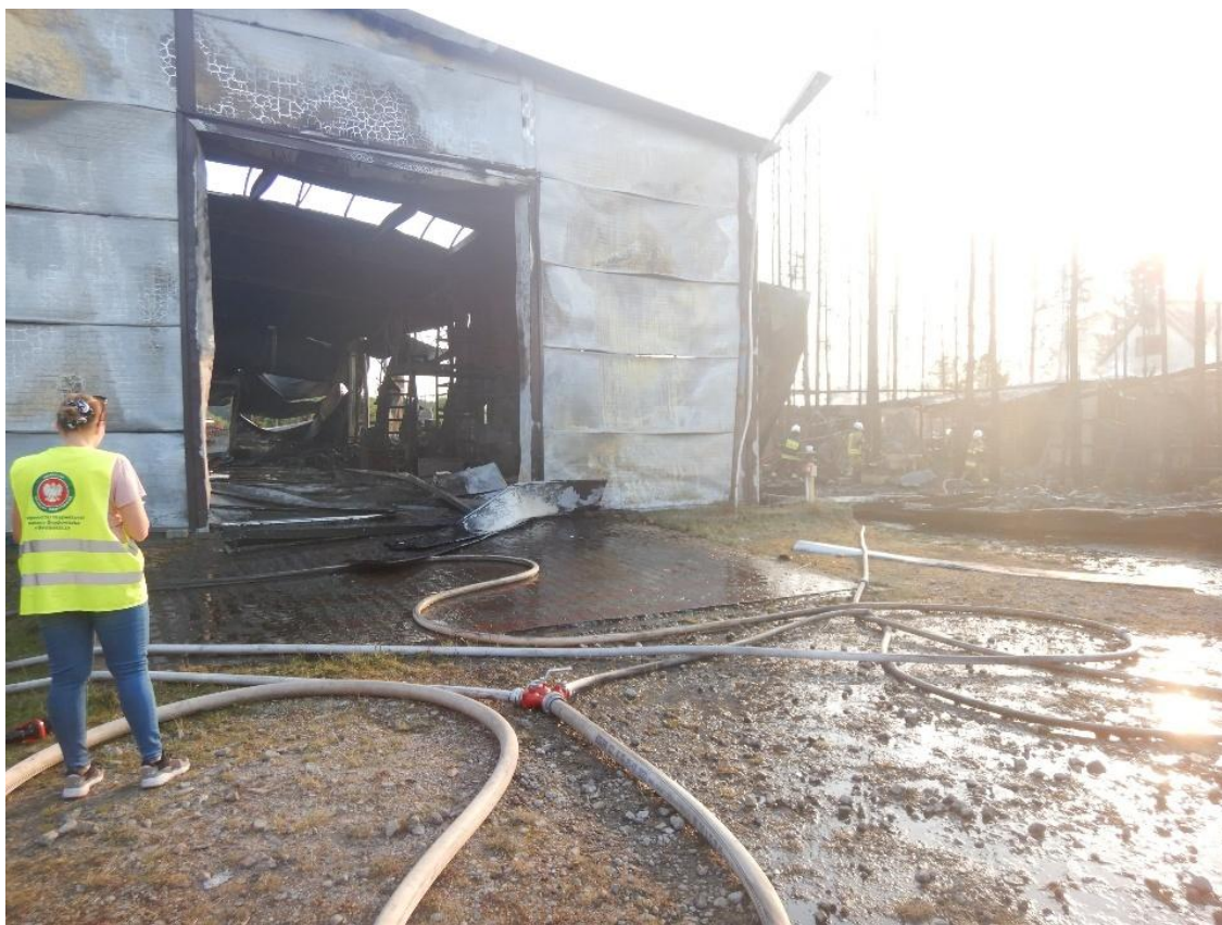
Czynności kontrolne inspektorów Delegatury WIOŚ we Włocławku realizowane na terenie powiatu aleksandrowskiego, w związku z wystąpieniem pożaru odpadów (sierpień 2025 r.)
